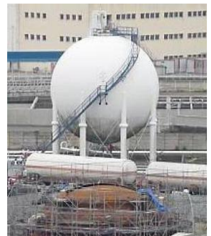
Contrôle de sphères de stockage de GPL par émission acoustique
